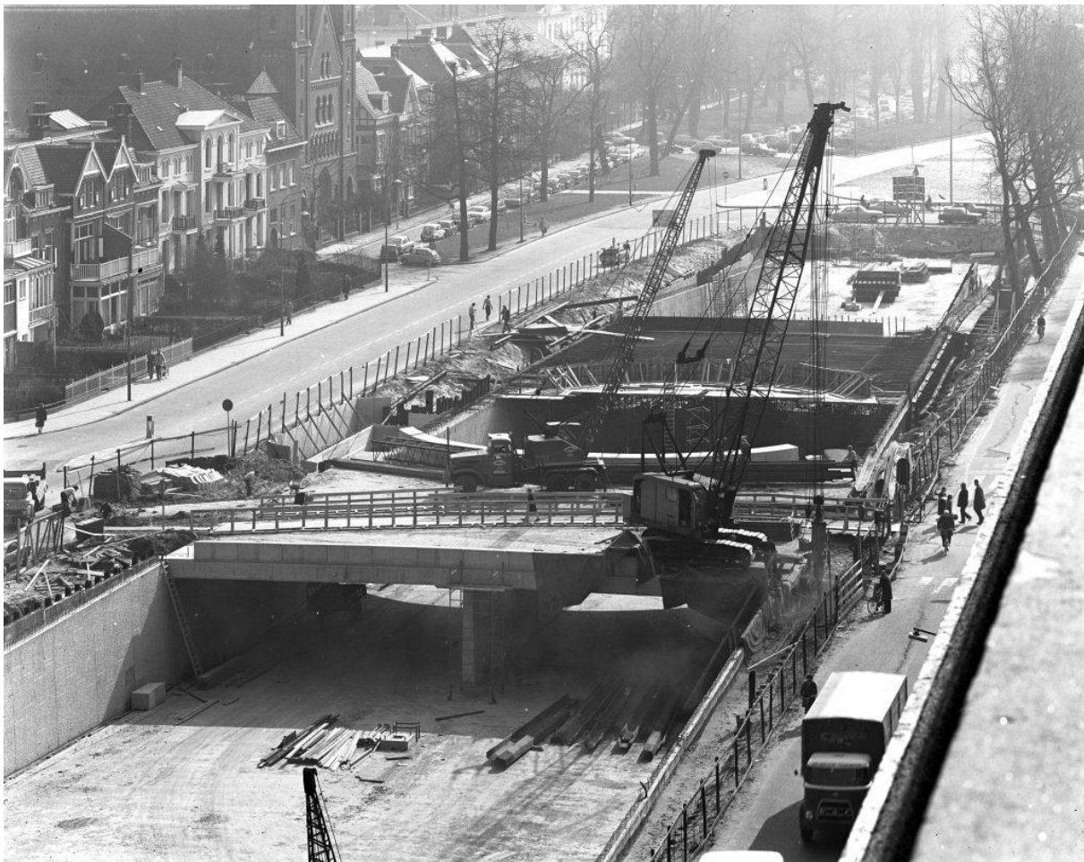
Afbeelding 6: Demping van de Catharijnesingel voor de aanleg van de nieuwe autoweg omstreeks 1970 (Bron: het Utrechts Archief)
