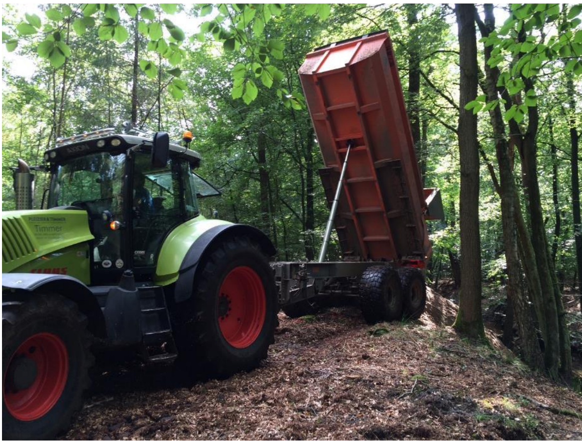
Figuur 3.2: Voorbeeld van een meekoppel-kans in een beekherstelproject in de Leuvenumse beek (Waterschap Vallei en Veluwe, Natuurmonumenten). Bij het suppleren van zand in de beek werd materiaal gebruikt dat was vrijgekomen bij een stuifzand-regeneratieproject in de buurt, waardoor geen zand van elders hoefde worden aangevoerd. Foto: Maarten Veldhuis.
